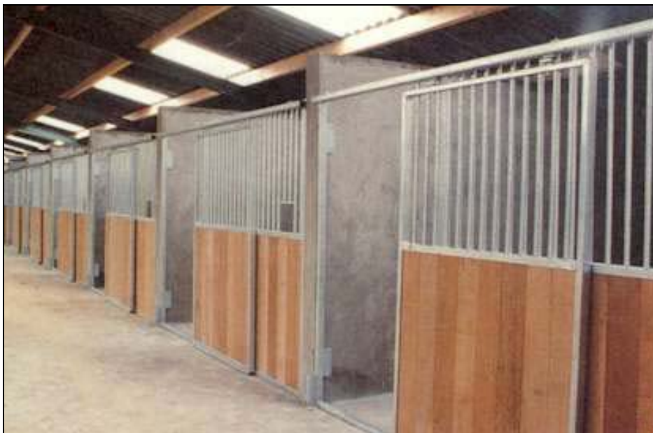
Figuur 7 Rij boxen met schuifdeuren en dichte tussenwanden
